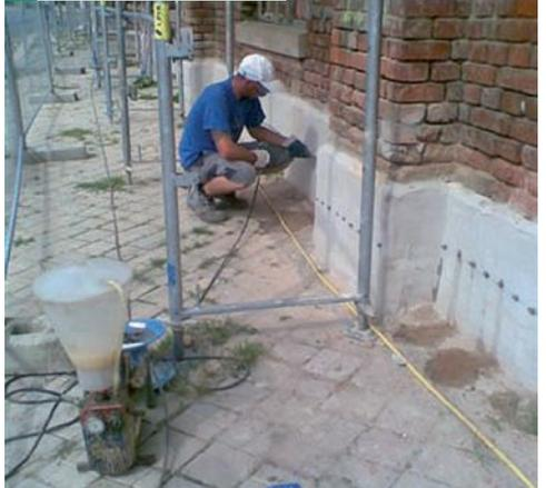
im Querschnitt möglich. Der Injektionsbaustoff auf Basis eines Silicon-Microemulsionskonzentrates wurde im Mischungsverhältnis von 1:7 in das Mauerwerk eingepresst (Bild 4 und 5).
