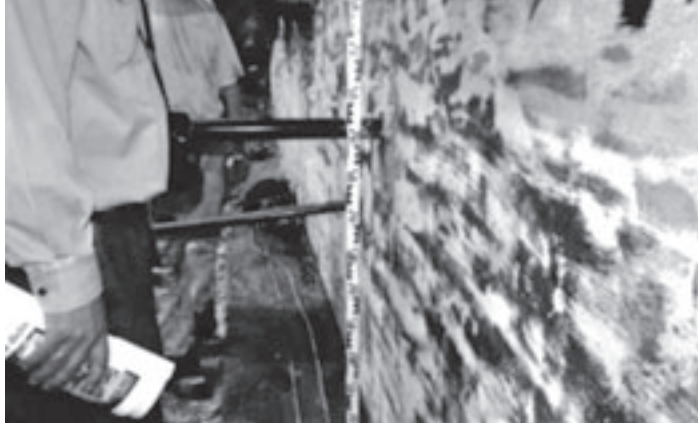
Bild 5 (oben): Überprüfung der Wandkonstruktion.
