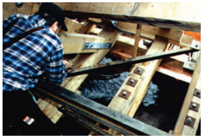
Bild 3: Schaumauftrag an der vertikalen Innenfläche am Gesims.
