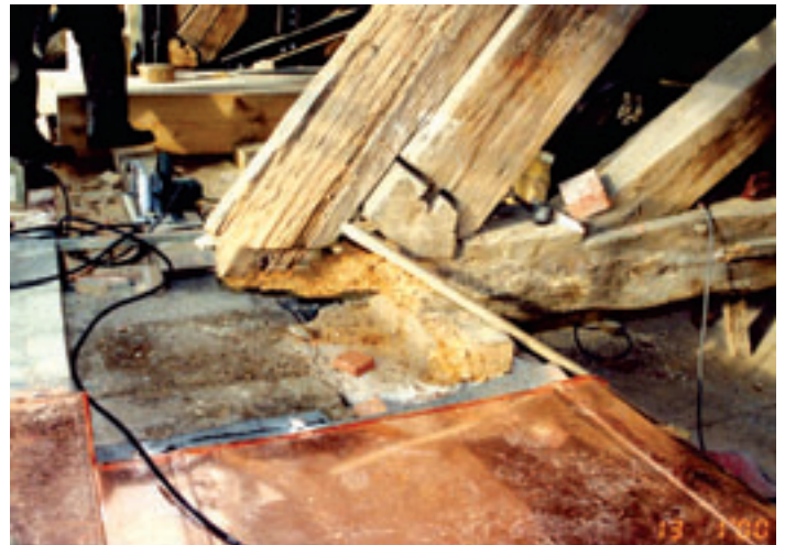
Bild 3: Schaumauftrag an der vertikalen Innenfläche am Gesims.
