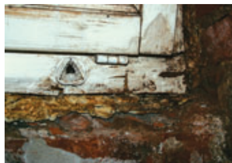
Bild 9: Deutlich erkennbare Holzschäden am Fensterrahmen.
