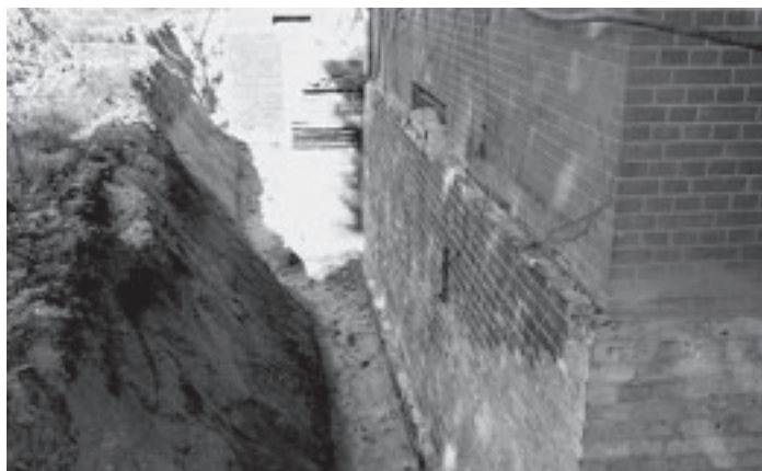
Grundmauerwerk mit teerhaltigem Anstrichsystem/Untergrundreinigungsverfahren.
