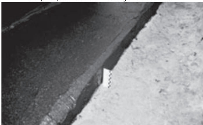
Bild 8 (oben): Überprüfung der Abdichtungshöhe am Sohleüberstand.
