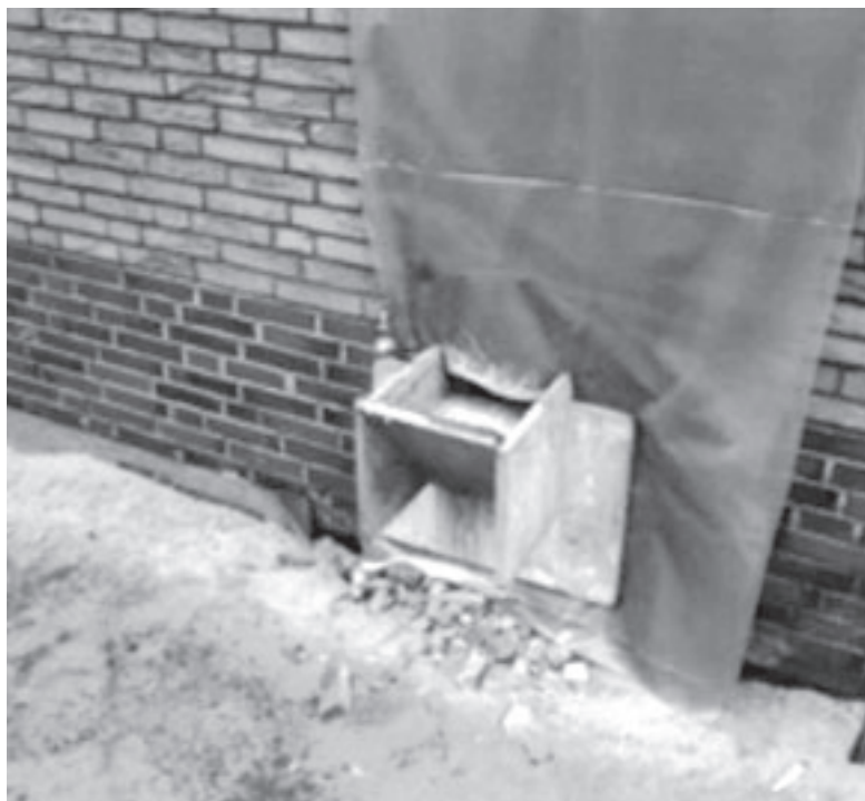
Bild 10: Ausbetonieren des nicht unterkellerten Bereichs mit Füllbeton.
