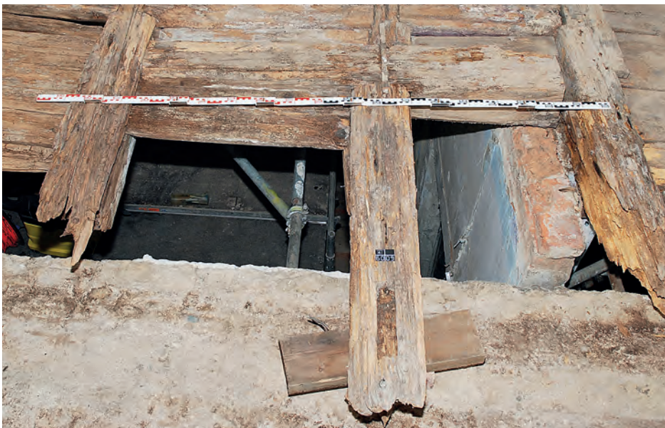
Herrenhaus, Dachgeschoss, Detail der stark geschädigten Ostseite der Decken.
