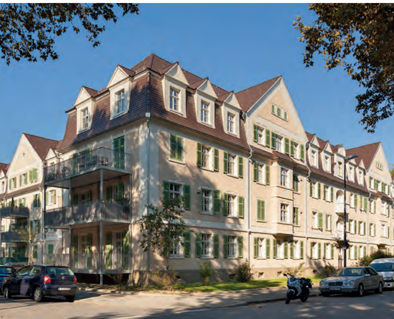
Deutschlands größtes Innendämm-Projekt „Neue Hofgärten“ in Ludwigshafen mit dem Energieeffizienzpreis „PROM des Jahres“ ausgezeichnet.
