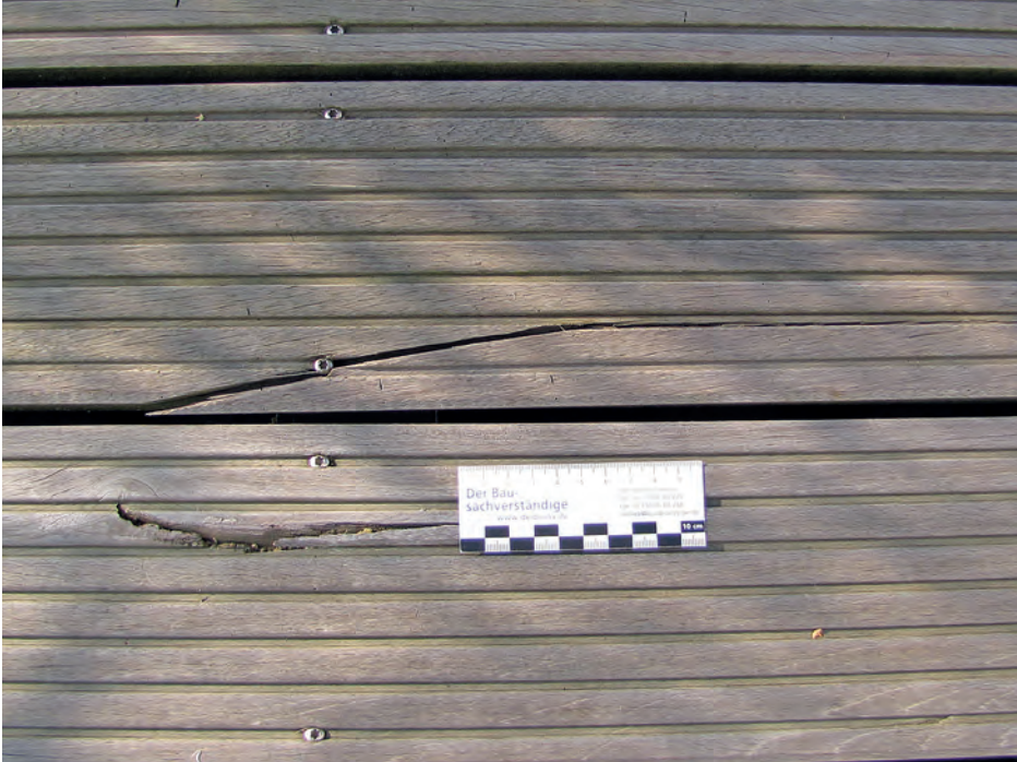
Abb. 3: Dielle mit großer Harzgalle sollte nicht verbaut werden. Dielle mit Riss im Bereich einer Schraube, wurde nachträglich erneuert.
