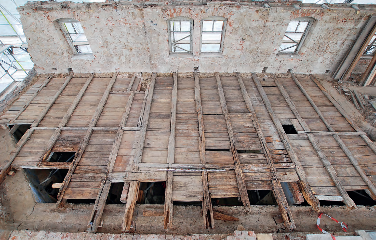
Vorwerk, Herrenhaus, Dachgeschoss, Oberseite der bemalten Decken nach Freilegung und Reinigung.
