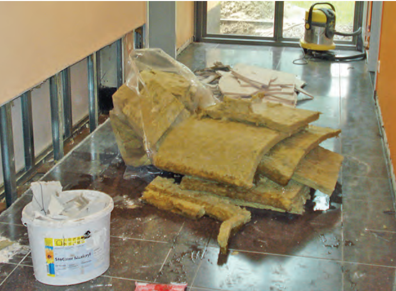
Bild 3: Wer kann sagen, was hier fehlt? Richtig – Fachleute! Denen wäre nämlich bewusst, dass Schutzmaßnahmen einzuhalten sind, vor allem, wenn im laufenden Betrieb eines Schülerlabors ein Schimmelpilzschaden zu beseitigen ist. Es fehlte hier sowohl ein Wegekonzept als auch eine Abschottung, ein Entsorgungskonzept ebenfalls und Warnhinweise sucht man vergebens! Auch sind die elektrischen Anlagen nicht abgesichert, der Schimmelpilzbefall ist noch erkennbar. Was sollte ein Kind wohl davon abhalten, hier mal die Nase reinzustecken?
