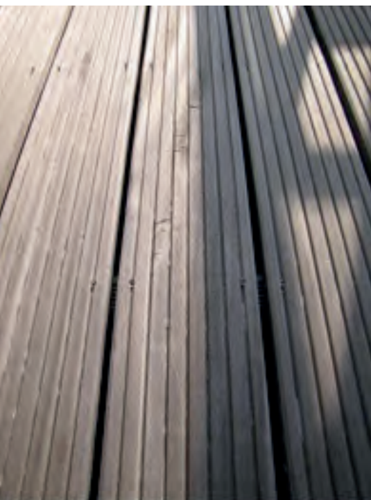
Abb. 4: Oberflächenrisse, ein natürliches Verhalten von drehwüchsigem Holz (hier Bangkirai).
