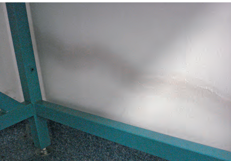
Bild 2: Feuchteschäden in schulischen Einrichtungen aufgrund von Baumängeln sind keine Seltenheit, hier wurde auf eine Drainage verzichtet. So gab es im gesamten Gebäude „nasse Füße“. Kurze Zeit später wurde im gesamten Trockenbau massiver Schimmelpilzbefall festgestellt.
