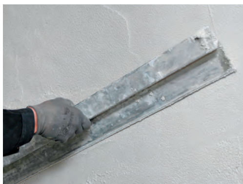
Der frisch aufgetragene Putzmörtel wird lattenrecht und nestfrei abgezogen.
