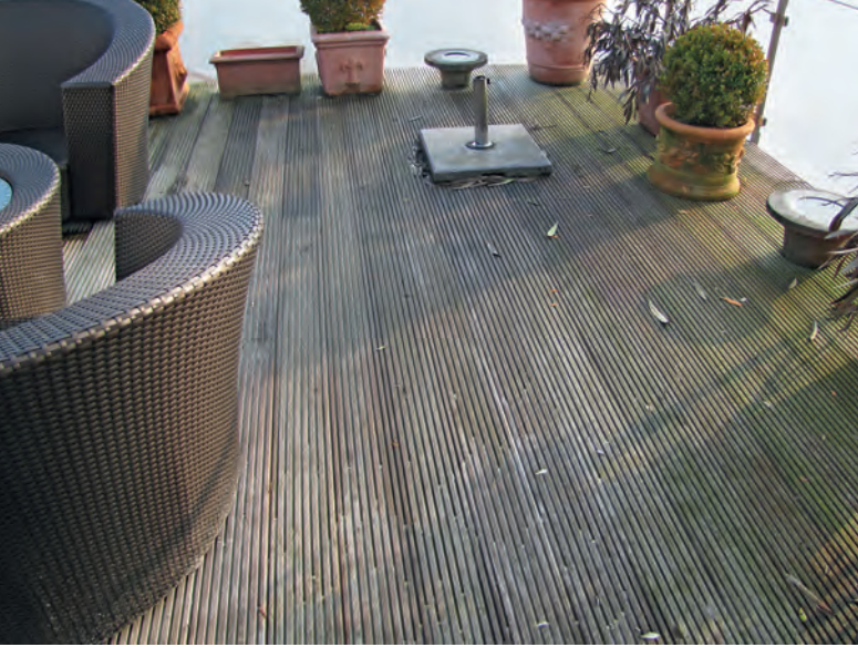
Abb. 1: Erstes Objekt. Zu eng verlegte Terrassendielen, die Fugen sind zugequollen.
