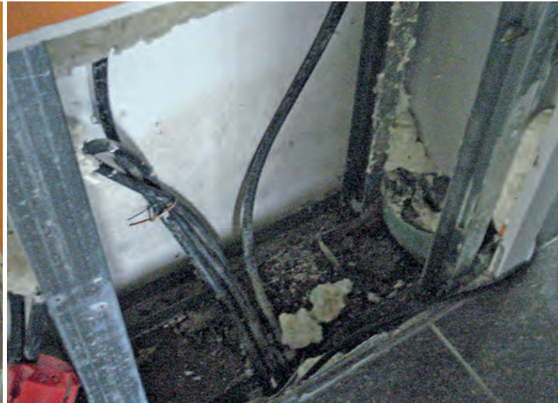
Bild 3: Wer kann sagen, was hier fehlt? Richtig – Fachleute! Denen wäre nämlich bewusst, dass Schutzmaßnahmen einzuhalten sind, vor allem, wenn im laufenden Betrieb eines Schülerlabors ein Schimmelpilzschaden zu beseitigen ist. Es fehlte hier sowohl ein Wegekonzept als auch eine Abschottung, ein Entsorgungskonzept ebenfalls und Warnhinweise sucht man vergebens! Auch sind die elektrischen Anlagen nicht abgesichert, der Schimmelpilzbefall ist noch erkennbar. Was sollte ein Kind wohl davon abhalten, hier mal die Nase reinzustecken?
