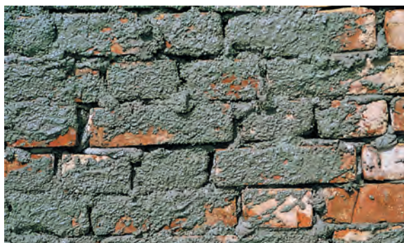
Ein netzförmiger Spritzbewurf bildet die Basis jedes Sanierputzsystems. Er sorgt dafür, dass sich der Sanierputz optimal verkrallen kann.
