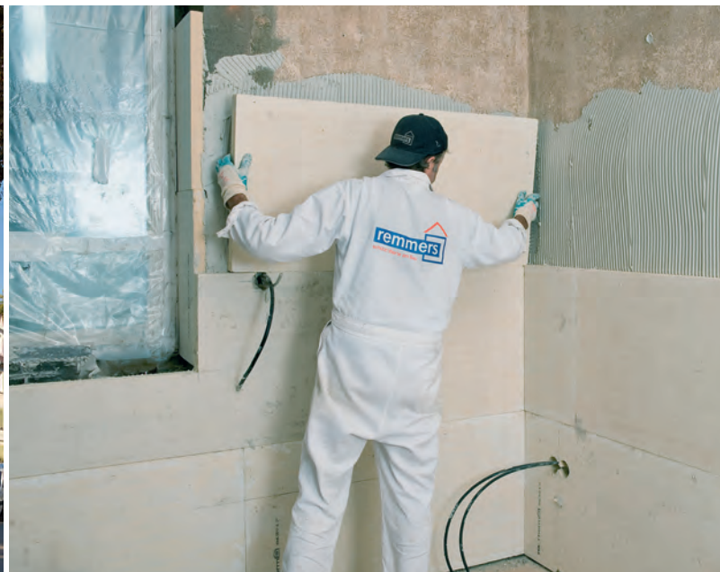
Innenwanddämm-System iQ-Therm ermöglicht den Erhalt der alten Fassade aus der Gründerzeit.
