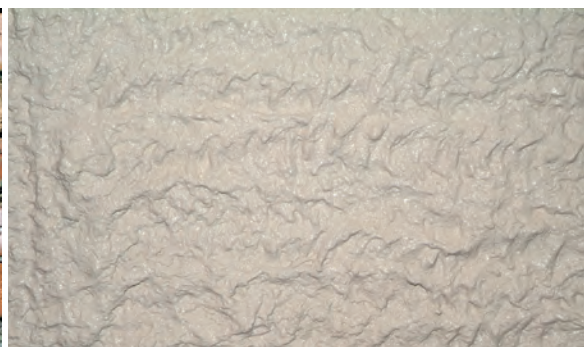
Der Sanierputz wird vollflächig in einer Schichtdicke von zwei bis drei Zentimetern aufgebracht.
