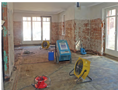
Abgeplatzter Putz, Salzkristallausblühungen, Fleckenbildung – Hochwasser hinterlässt sichtbare Spuren.
