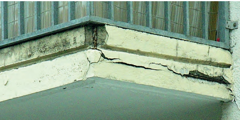
Foto: Bundesgütegemeinschaft Instandsetzung von Betonbauwerken e. V. (ib).
