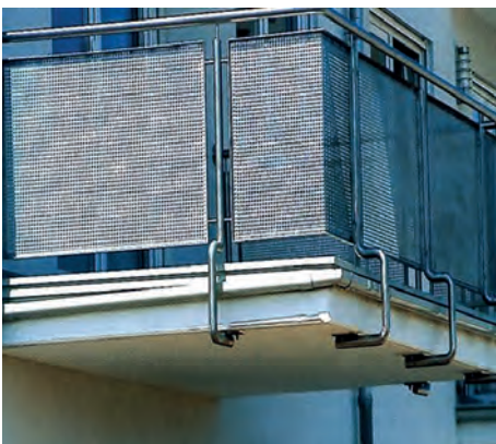
Balkongeländer unterhalb der Balkonkragplatte.
