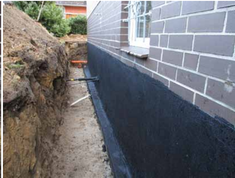
Während der Abdichtungsarbeiten.
