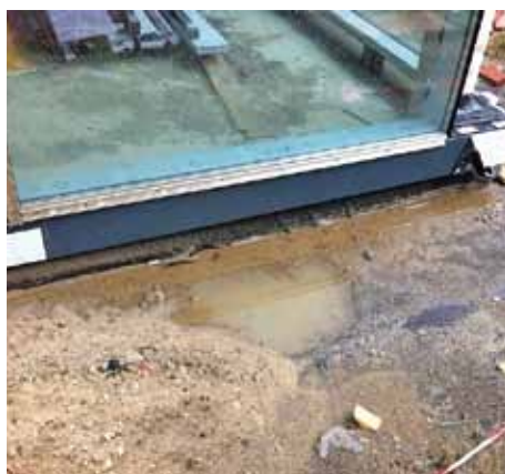
Wasserbeanspruchung am Gebäudesockel.
