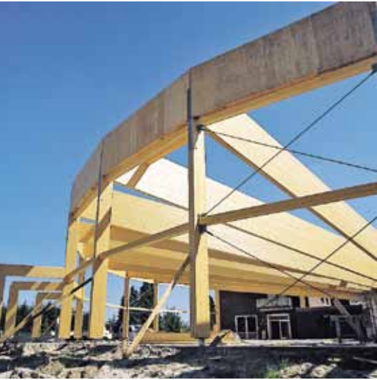
Oben: Imprägniergrund Plus eignet sich als vorbeugender Holzschutz für Hallen mit einer Leimbinderkonstruktion.
