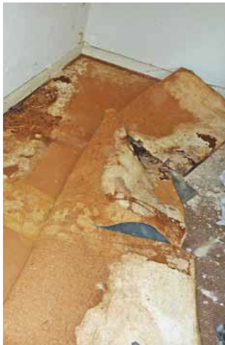
Pilz- und Insektenbefall des Fußbodens in der Hochzeitssuite. Foto: ©Kirsten Liesner
