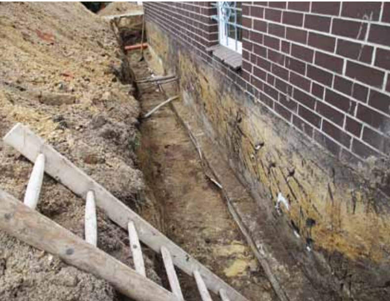
Nach dem Aufgraben.
