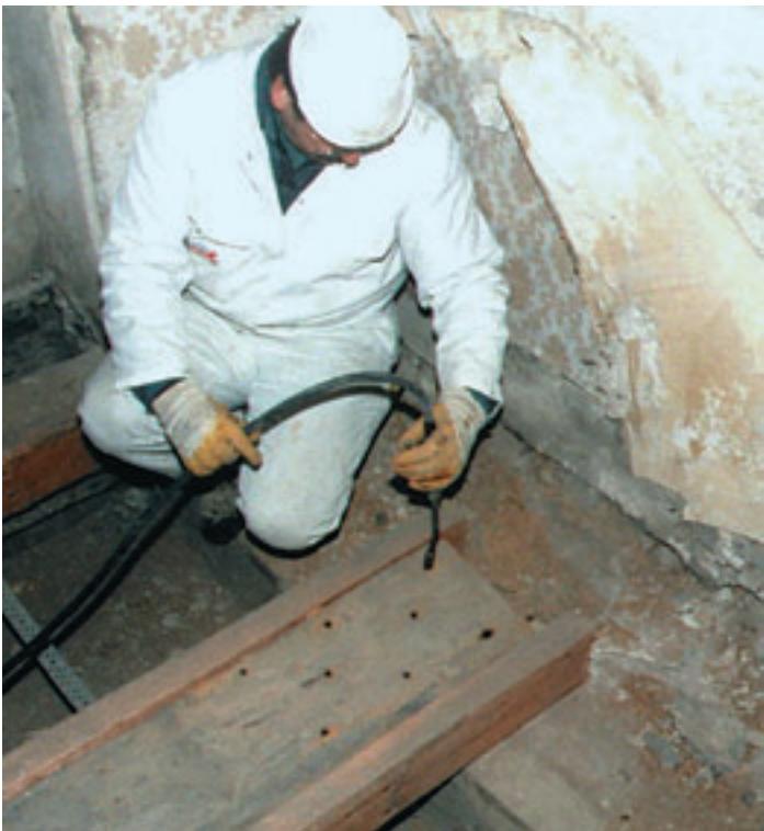
Druckinjektion in einem Balkenkopf
