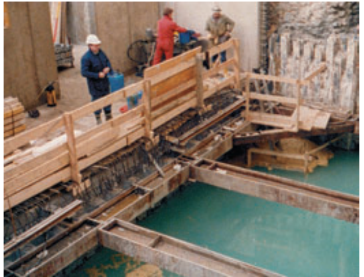
Das Problem... Parkplätze sind rar in der Münchner Innenstadt. Ein Hotel hat einen Auto-Paternoster, der 36 m in die Tiefe führt. Bei der Renovierung wurde eine Spundwand undicht, Wasser überflutete die gesamte Parkgarage und hinterspülte die Spundwände.
