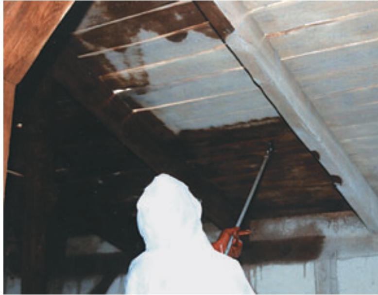
Holzschutzbehandlung (Sprühverfahren) in einem Dachstuhl
