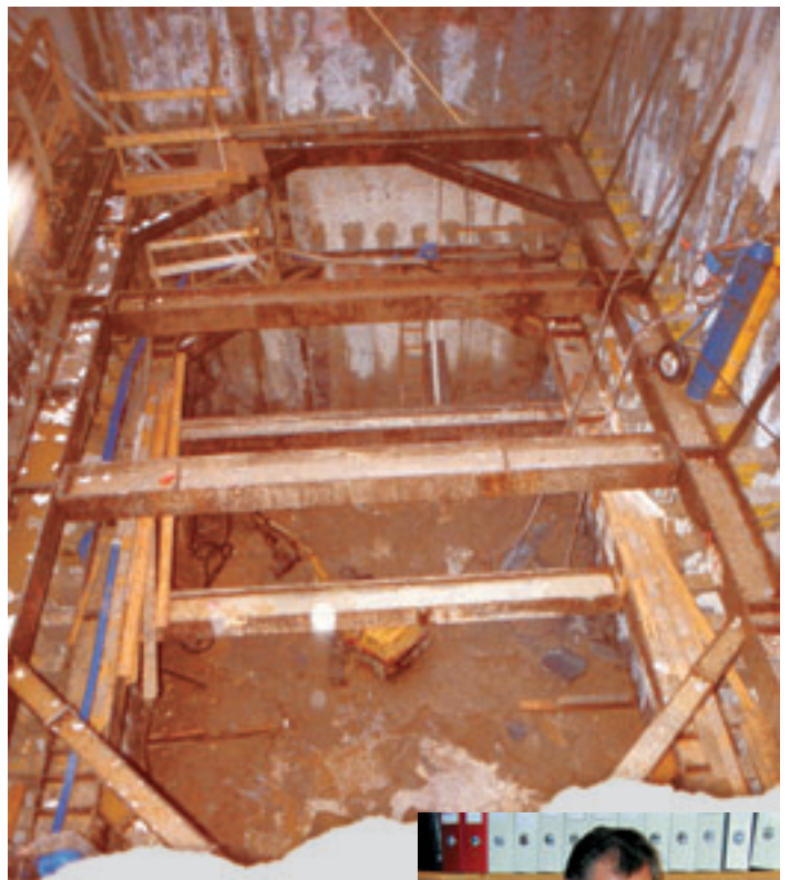
Das Problem... Parkplätze sind rar in der Münchner Innenstadt. Ein Hotel hat einen Auto-Paternoster, der 36 m in die Tiefe führt. Bei der Renovierung wurde eine Spundwand undicht, Wasser überflutete die gesamte Parkgarage und hinterspülte die Spundwände.
