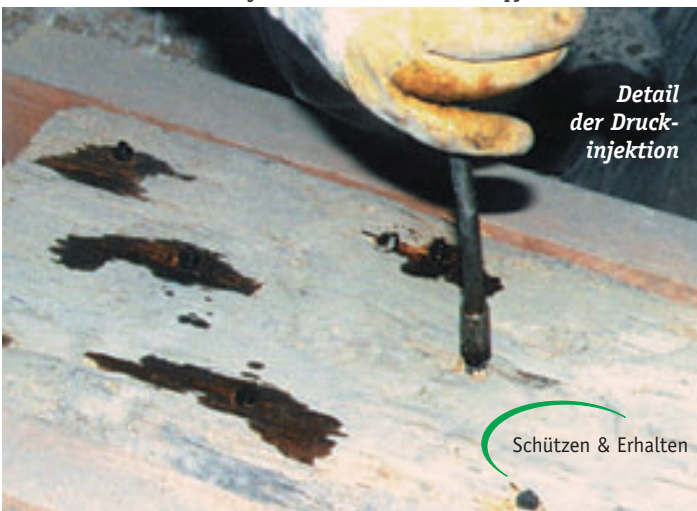
Druckinjektion in einem Balkenkopf
