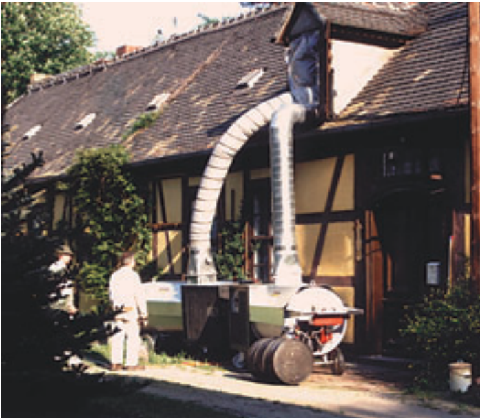
Heißluftbehandlung an einem Dachstuhl
