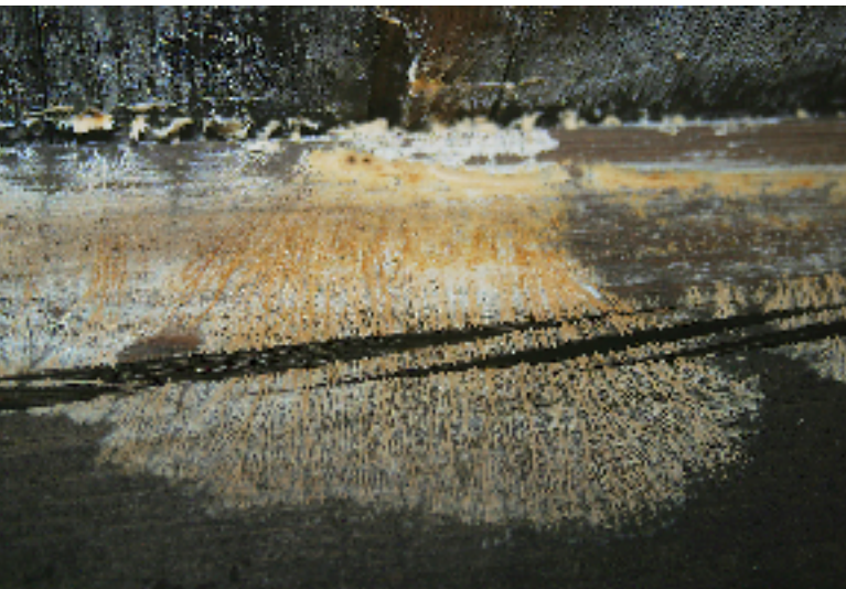
Bild 3: Oberflächenmyzel an der Sparrenflanke.
