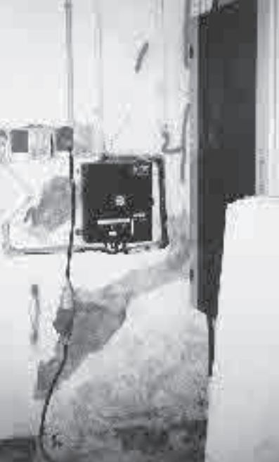
Links: Vorgefundenes Schadensbild (Risse). Oben: Grafische Darstellung der Risse. Rechts: Riss freigelegt (Putz abgeschlagen).
