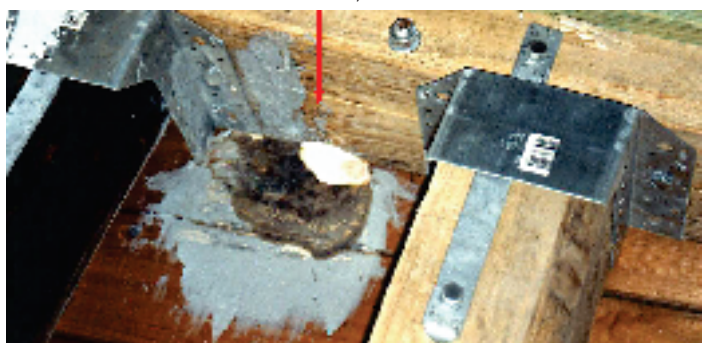
Abb. 4. Innenseite: Fruchtkörper wurde unsachgemäß und ohne die Ursache zu beseitigen bemalt; das Mycel im Holz wird davon nicht betroffen und schiebt einen neuen Fruchtkörper heraus (!); Foto: P. Newcombe.
