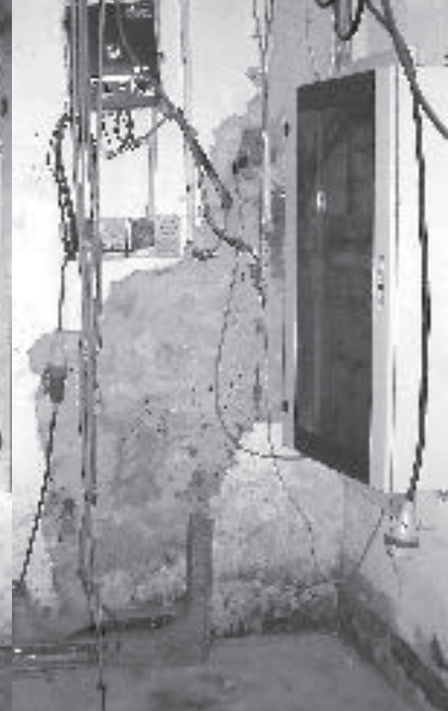
Oben: Riss verdämmt, unten: Packer gesetzt.
