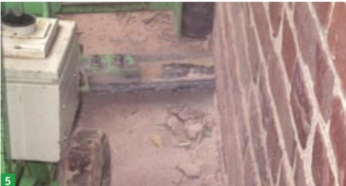
1. Nach dem abschnittsweise über den gesamten Querschnitt Durchtrennen des Ziegelmauerwerks wird die aufgetrennte Lagerfuge mit einem Fugenreinigungsmesser von Sand und Ziegelresten befreit und ggf. ausgesaugt (Bild 2–5).
