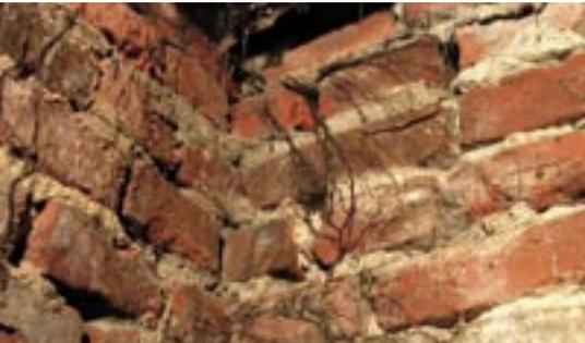
Abb. 5: Dunkle Stränge des Braunen Kellerschwammes wachsen am Mauerwerk und durchwachsen es.
