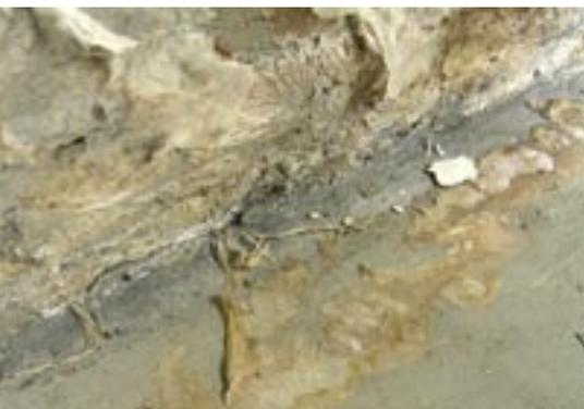
Links unten, Abb. 3: Graue Stränge des Wilden Hausschwamm wachsen am Mauerwerk und durchwachsen es.
