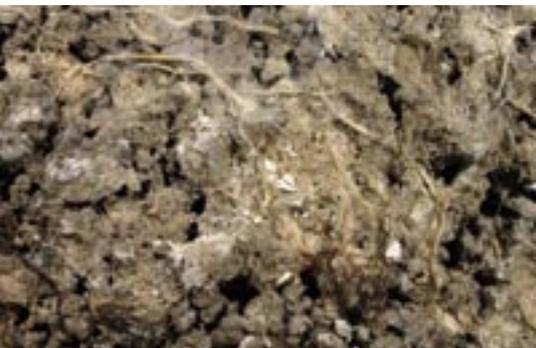
Abb. 6: Stränge des Haus-Tintlings wachsen am Mauerwerk und durchwachsen es.
