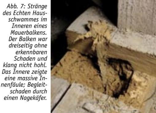
Abb. 7: Stränge des Echten Hausschwammes im Inneren eines Mauerbalkens. Der Balken war dreiseitig ohne erkennbaren Schaden und klang nicht hohl. Das Innere zeigte eine massive Innenfäule; Begleit-schaden durch einen Nagekäfer.
